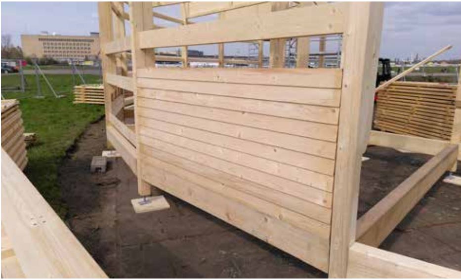
Leicht auf- und abzubauen: Die Fassadenteile wie auch vieles andere sind mit Passverbindern hergestellt und brauchen nur eingehängt zu werden. Foto: Kernzone gGmbH
