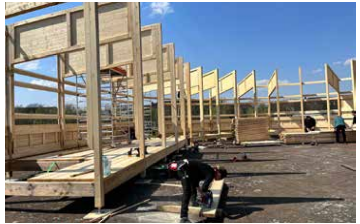
Das Skelett der Seiten- und Hinterbühne: Beim Aufbau halfen die Zimmererlehrlinge der Knobelsdorff-Schule. Foto: Kernzone gGmbH
